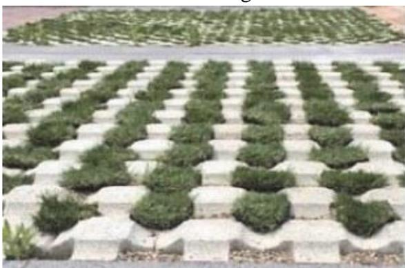
**Figura 35- prefabbricato in calcestruzzo.** Fonte: [sevilla.org/respira/respira-nervion/renovacion-de-la-infraestructura-de-emasesa](http://sevilla.org/respira/respira-nervion/renovacion-de-la-infraestructura-de-emasesa)
